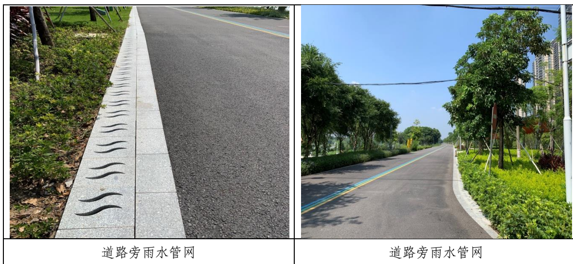
图 4-3 监测过程工程措施图
